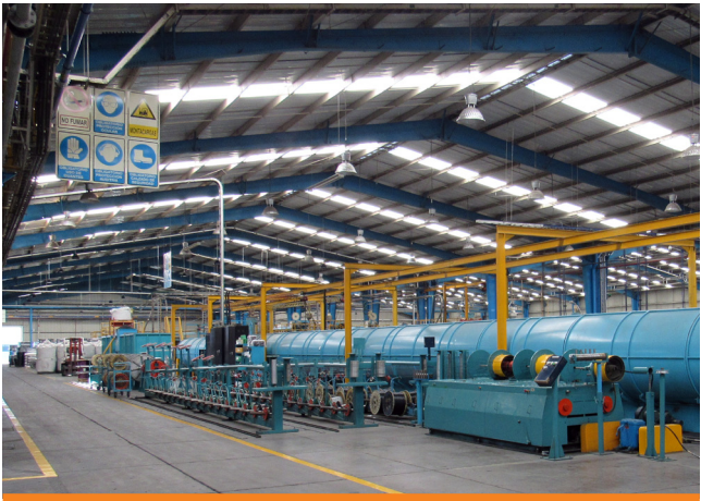
Iluminación solar, CONDUTEL (Grupo CONDUMEX).
