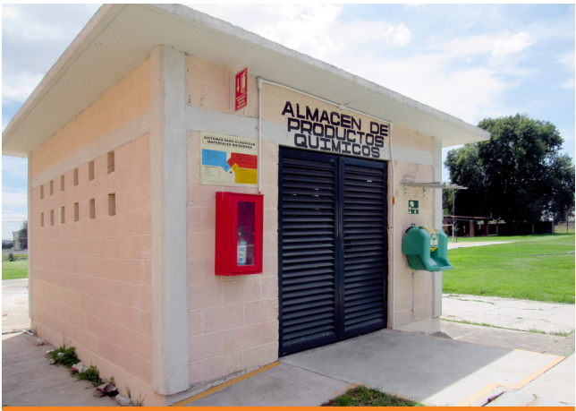
Almacén de productos químicos Arcomex (CONDUMEX).
